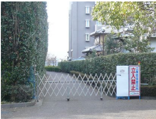
⑤ 工事のため、第3駐車場方面からは進入できません。
