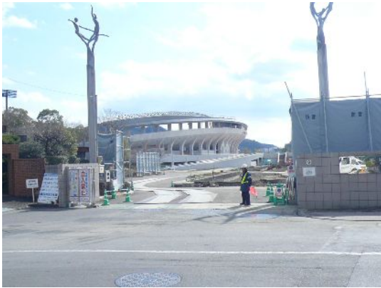
④ マラソングート 工事のため、マラソングートからは進入できません。
