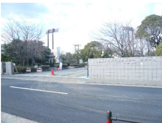
③ 南ゲート 「世界イベント村南臨時駐車場」からはこちらからが便利です。ただし、工事車両進入口にもなっていますので、通行の際にはご注意ください。
