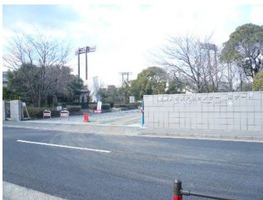
③ 南ゲート 「世界イベント村南臨時駐車場」からはこちらからが便利です。ただし、工事車両進入口にもなっていますので、通行の際にはご注意ください。
